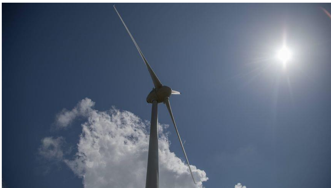
Éolienne en Charente-Maritime
