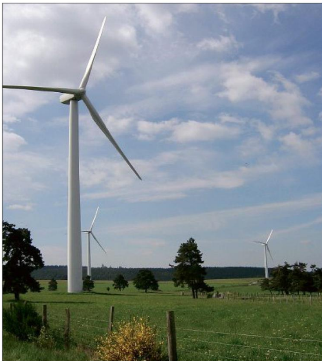
PARC ÉOLIEN. Implanté entre Gentioux et Peyrelevade, il est composé de six machines. ARCHIVES
