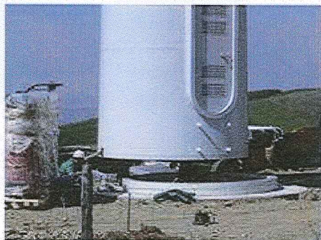
Assemblage des tronçons de mât
