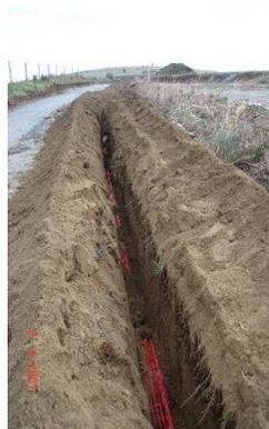
Réalisation de la tranchée et de la pose du câble simultanément
