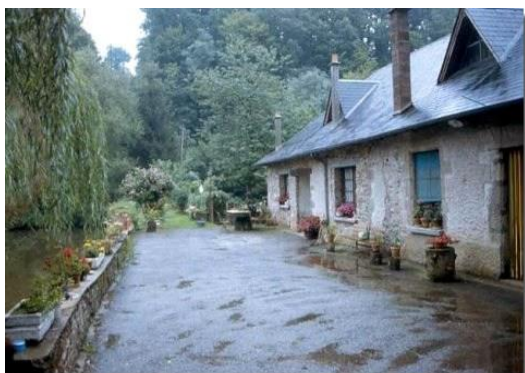
Digue et moulin-habitation
