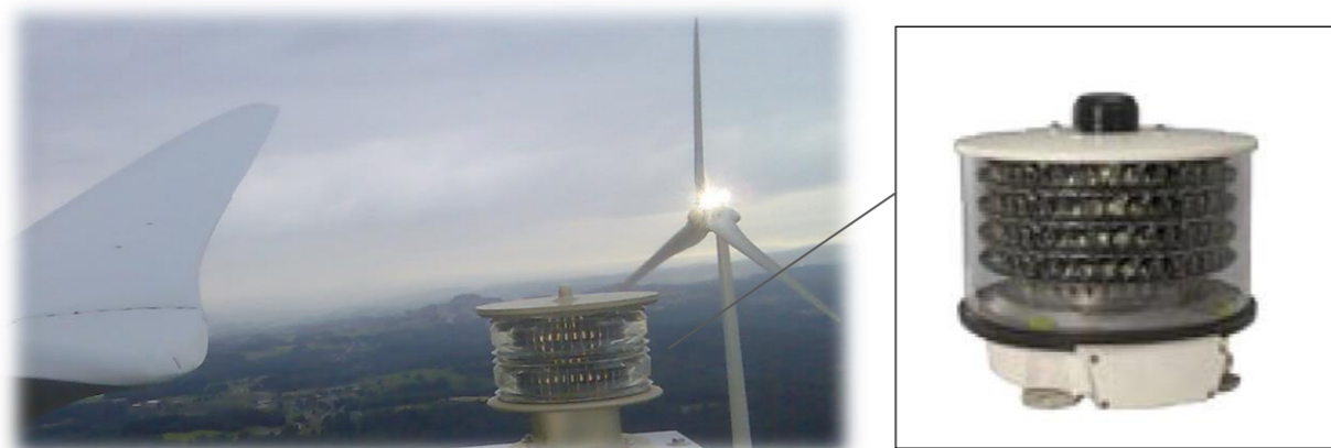
Figure 43 : Balisage d'une éolienne
