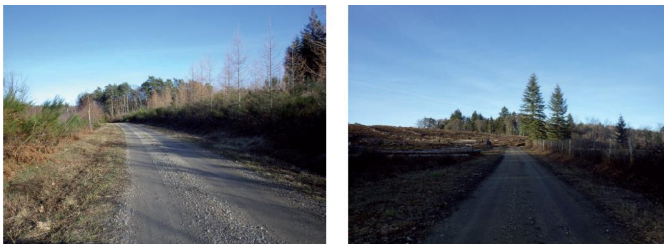
Photographie 57 : Exemples de pistes existantes (pistes à renforcer) (source : ENCIS Environnement)
