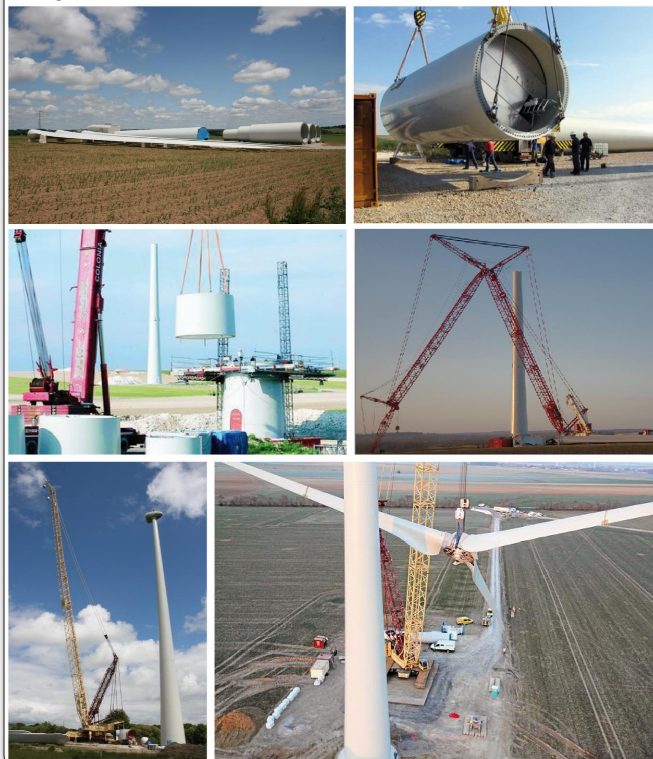
Montage d'une éolienne
