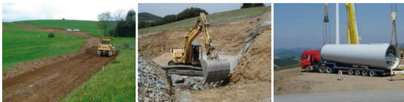
Photographie 50 : Illustrations d'un chantier éolien
