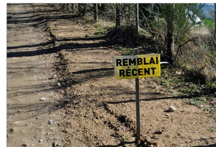
Photographie 46 : Exemple de remblai des tranchées électriques le long d'une piste
