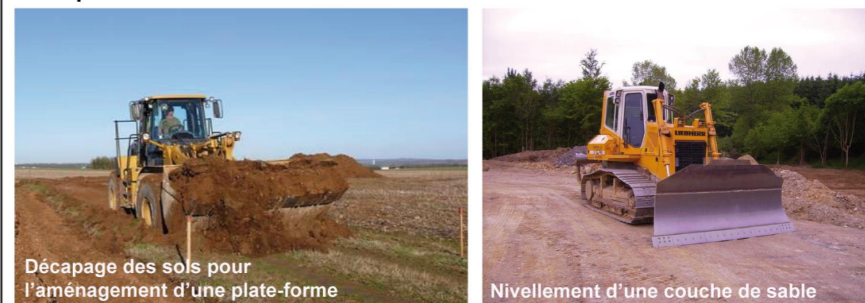
Photographie 41 : Exemples d'engins de travaux de VRD
