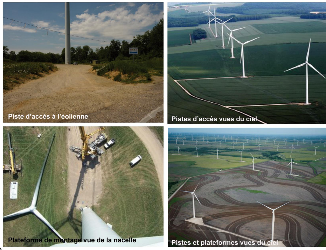
Photographie 39 : Exemples de plateformes de montage et de pistes
