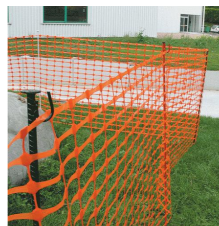
Dispositif de mise en défens.
