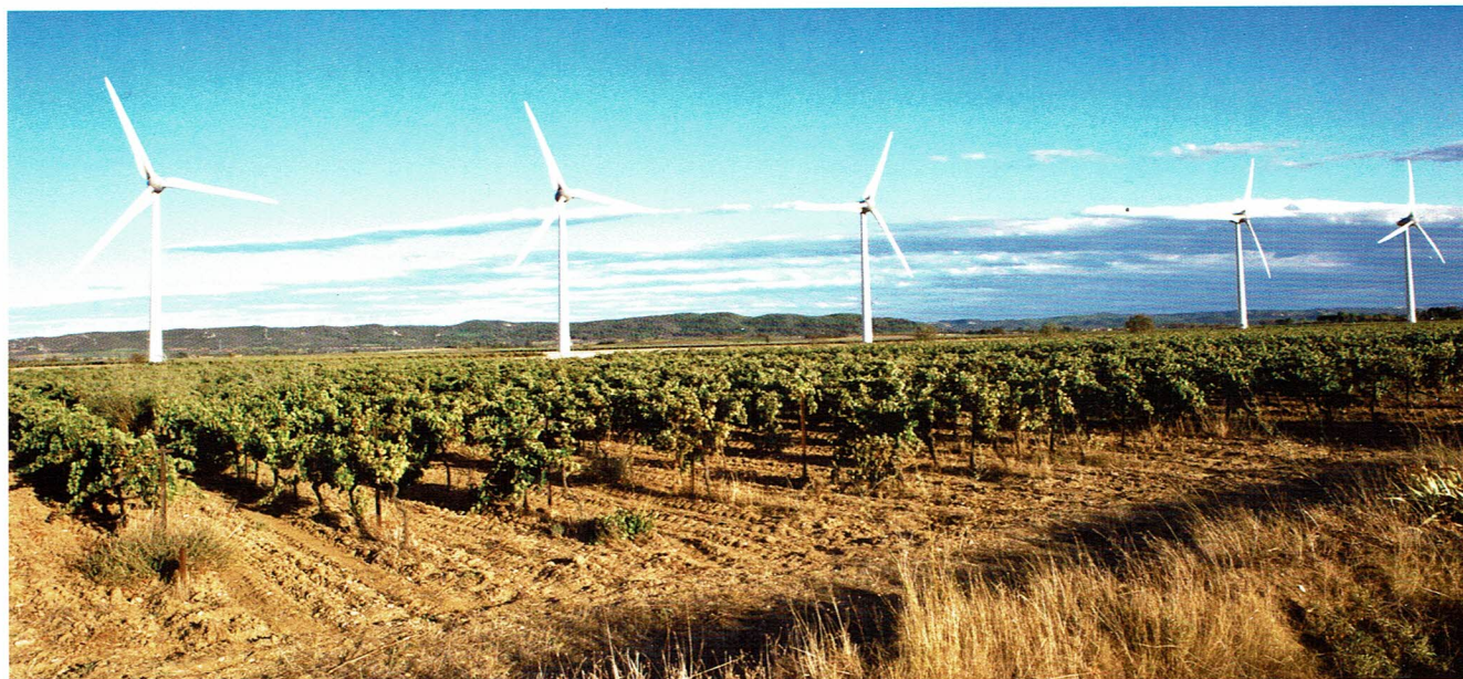
Parc éolien de Cruscades (11)
