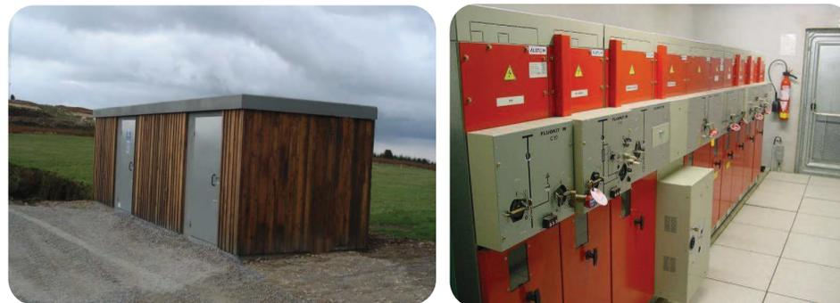
Figure 3 : modèle et intérieur d'un poste de livraison © VALECO
