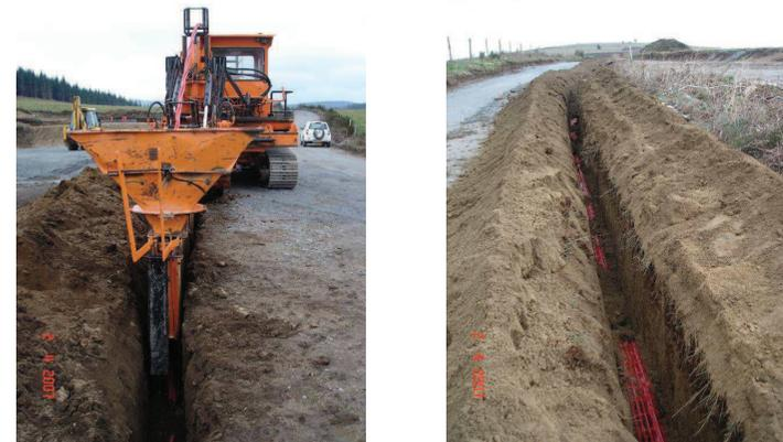
Photo 3 : réalisation en simultanée de la tranchée et de la pose du câble © VALECO
